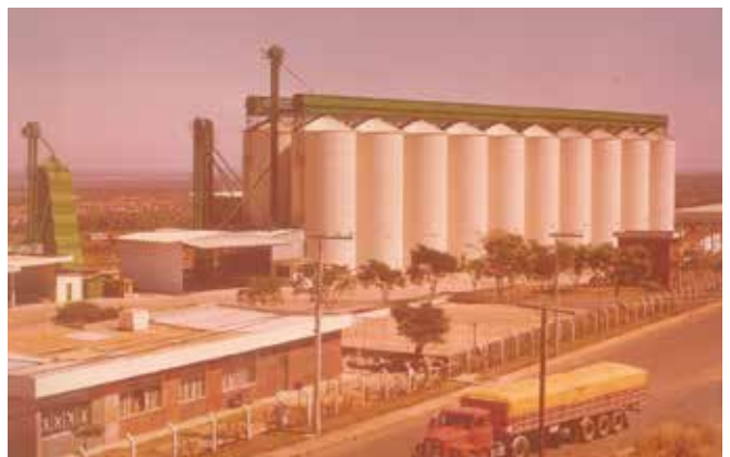
UNITÉ DE STOCKAGE D'UBERLANDIA
