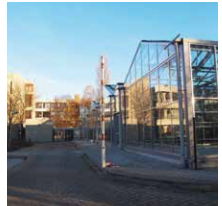
VUE EXTÉRIEURE DES SERRES
