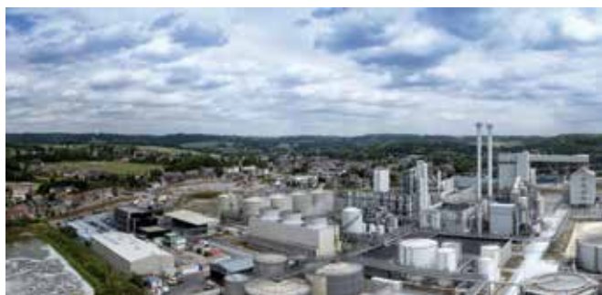
VUE PANORAMIQUE DE L'USINE DE BIOWANZE
